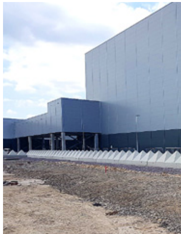
Bariéry ihlanového tvaru zvané Toblerone sú vyrobené v závode ISK Preša Kysak a našli svoje uplatnenie aj na stavbe Jaguar Land Rover, napríklad pri administratívnej budove.
