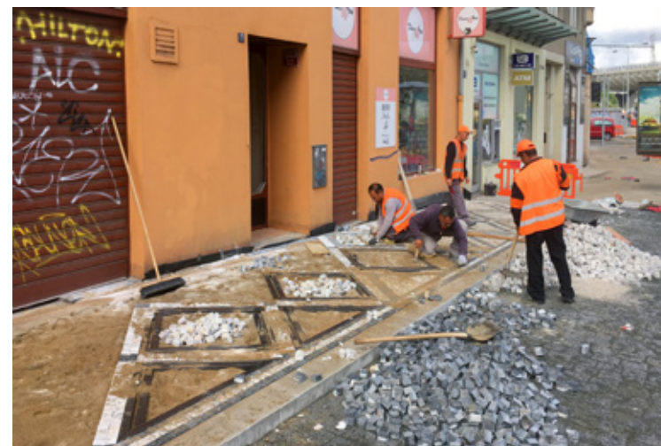
„Už máme signály, že některé firmy kvůli stavbám velkého polyfunkčního domu a obytného domu pod Vítkovem nutně musí jezdit přes náš úsek, ale když tam pokládáme obrubníky a skládáme chodník, není zrovna dobré, aby tudy jezdila těžká doprava,“ komentuje situaci Vít Duda. Na snímku dláždění parkovacích zálivů a skládání chodníkových mozaiek.
