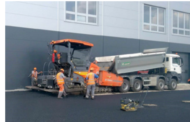
Na celom diele bolo položených vyše 55 tisíc ton asfaltu.
